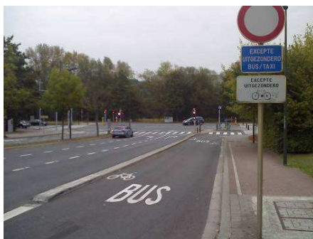
Bus-/Fahrradspur als Ampelumgehung für Rechtsabbieger mit einem geschlossenen Profil und Fahrradstraßensymbolen (D. Dufour)
